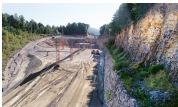
Die Auffüllung der Oberegg – via Förderband – geht zügig voran.
